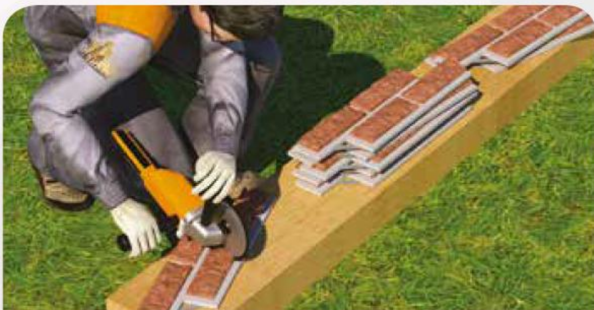
5. Использование болгарки для подпилки плитки
