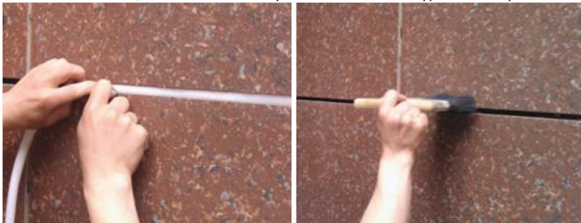
5. Очищение швов панелей, заполнение в них уплотнительного шнура полистирола
