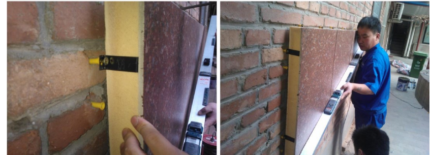
6. Наклеивание малярного скотча, вливание атмосферостойкого силиконового герметика
